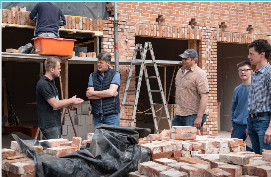
Dank des tatkräftigen Anpackens vor Ort liegt der erste Bauabschnitt mit der Sanierung der Dorfscheune voll im Zeitplan. Dabei kommen auch alte Verblender wieder zum Einsatz.
